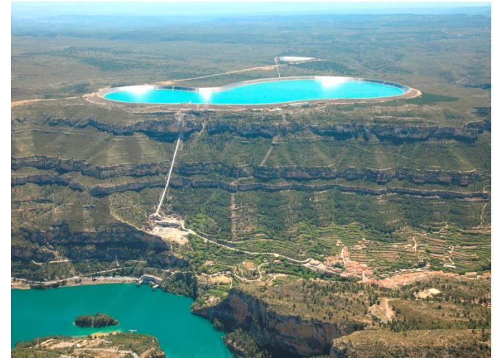
Aprovechamiento hidroeléctrico reversible Cortes La Muela
