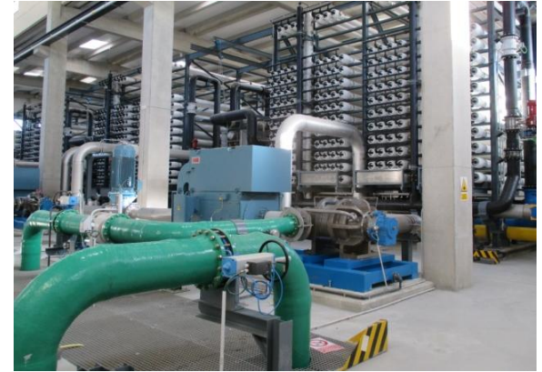
Membranas de ósmosis inversa de la desalinizadora de Mutxamel
